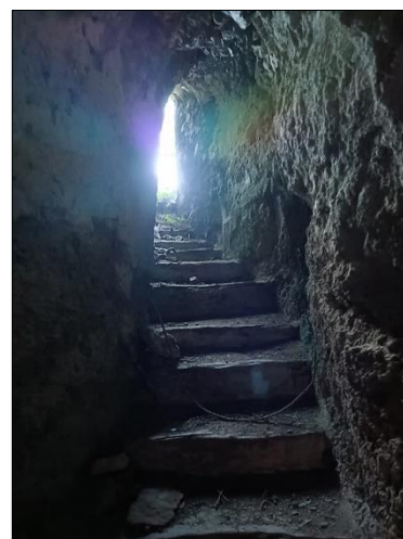
Figure 13 : Escalier menant aux galeries
