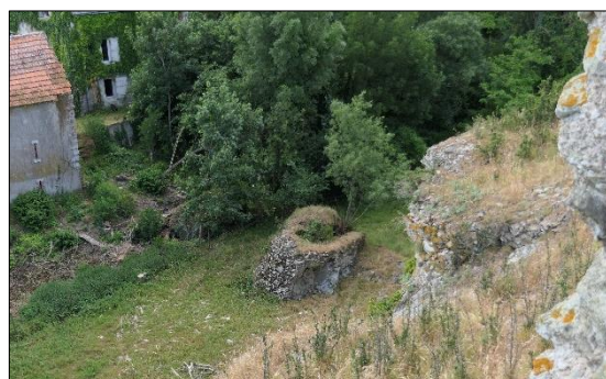
Figure 27 : Maçonnerie en contrebas du rocher de Saint-Offange, peut-être une pile de pont (Ronan Durandière)
