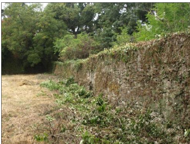
Figure 14 : Mur d'enceinte de la basse-cour (LEBLANC T., p.23)
