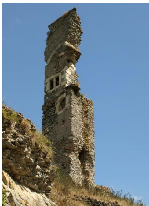
Figure 28 : Pan de mur du château (LEBLANC T., p.32)
