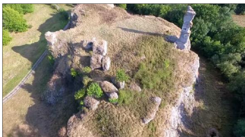
Figure 26 : Vue aérienne du rocher Saint-Offange. On observe un pan de mur encore début et des gros blocs de maçonnerie effondrés. Photo Nicolobrica. (LEBLANC T., p.7)
