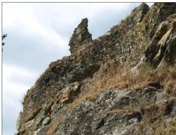
Figure 29 : Base de courtine s'appuyant sur l'escarpe rocheuse (LEBLANC T., p.33)
