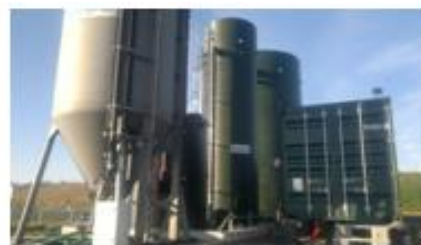
Traitement des lixiviats (ultrafiltration)
