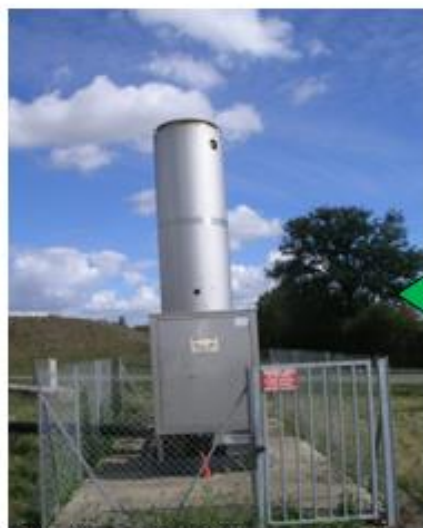
Brûlage des biogaz dans la torchère
