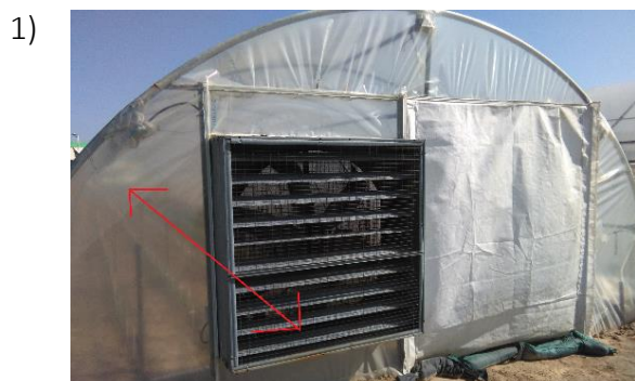
Figure 13: Flux d'aération dans les tunnels
