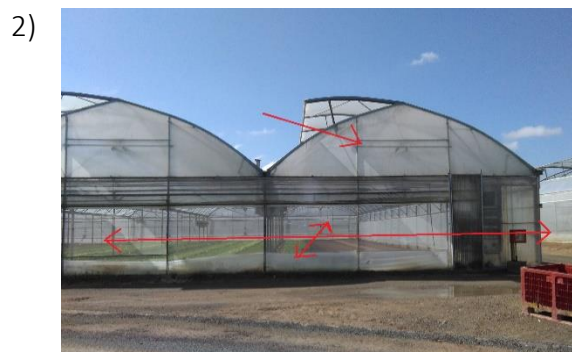
Figure 14: Flux d'aération dans les multi chapelles
