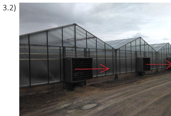
Figure 15: Flux d'aération dans les couloirs des serres verre (HS), vue extérieure
