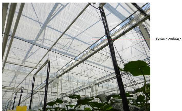
Figure 12 Photographie des écrans d'ombrage (Ctifl)
