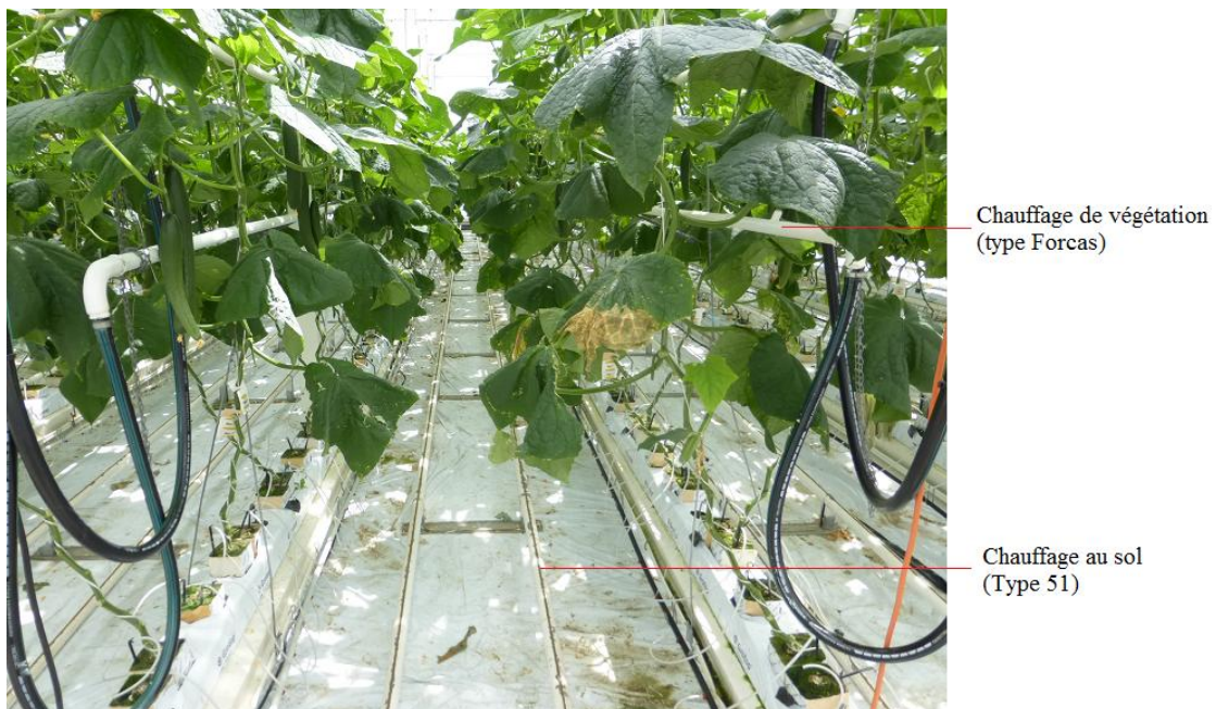
Figure 6 Photographie des tuyaux de chauffages (Ctifi)
