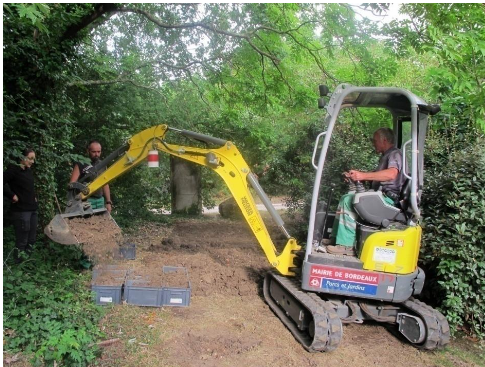
Figure n°25 : Photographie de la mini-pelle remplissant les caisses de sol pollué (Sourzat, Août 2016, 5 Avenue du docteur Schinazi 33300 Bordeaux)
